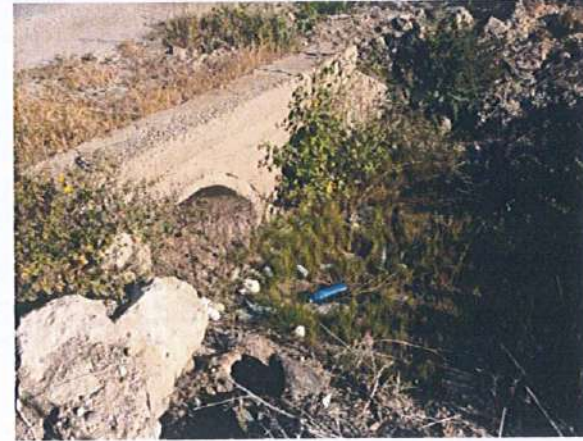
Margen derecho A-370
