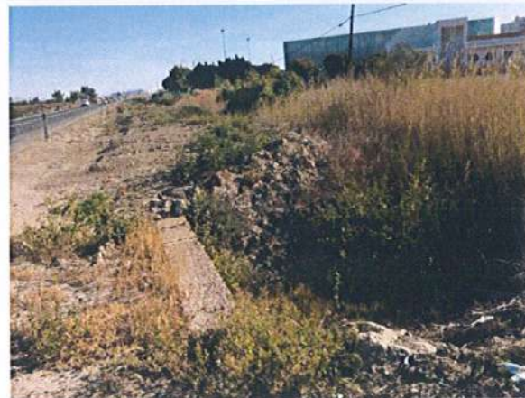
Margen derecho A-370
